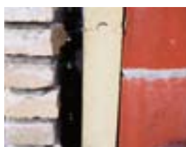
Isolatie van spouwmuur met PUR.
