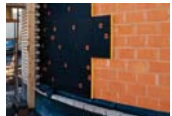
Metselen van binnenmuur. Daarna isolatie aanbrengen. Tot slot gevelsteen optrekken.
