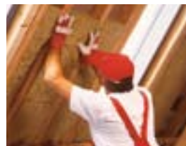
Isolatie van hellend dak met minerale wol.
