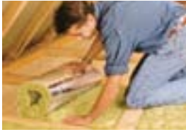
Isolatie van de zoldervloer met minerale wol.
