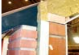
Geen koudebrug via continu doorlopende isolatielijin.
