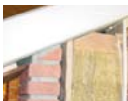
Isolatie van spouwmuur bij houtskeletbouw met minerale wol.
