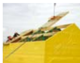
Isolatie van hellend dak met isolerende dakelementen.
