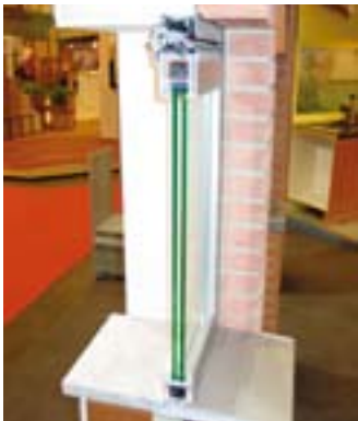
Doorsnede van venster met hoogrendementsbeglazing en ventilatierooster.
