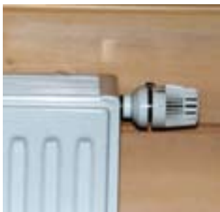
Radiator met thermostatische kraan.
