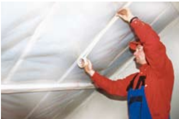
Luchtdicht maken door het tappen van het dampscherm.
