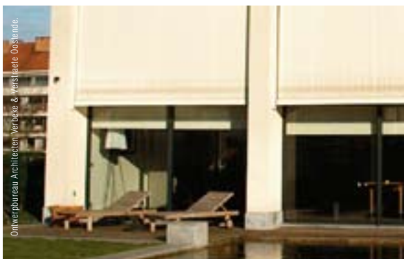
Oververhitting vermijden door gebruik van zonnewering.
